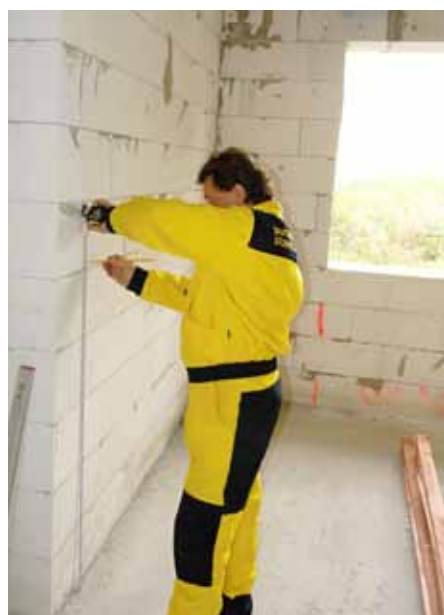
Vyměrování vypínačů v pórobetonu Ytong.
