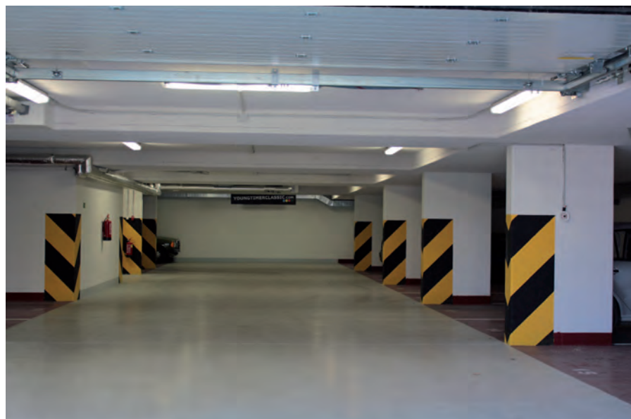
Obr. 4 Bytový dům Dolní Chabry
