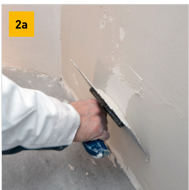
Nanášení stěrky ocelovým hladítkem
