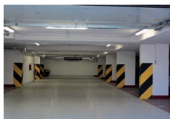
Bytový dům v Dolních Chabrech. Podhledy z tepelněizolačních desek Ytong Multipor dobře působí i bez dodatečné povrchové úpravy.
