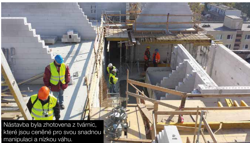
Původní objekt byl navýšen o nástavbu přímo na konstrukci původní střechy.
