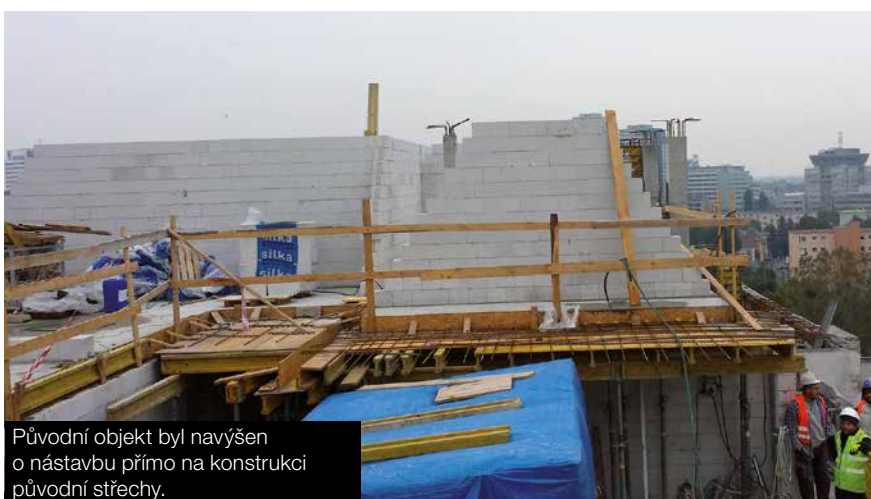
Bourací práce odhalily zachovalý skelet, který bylo možné využít bez nákladnějších oprav.
