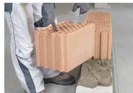
Zakládací tvárnice eliminuje vztlínání vlhkosti na stavbě.
