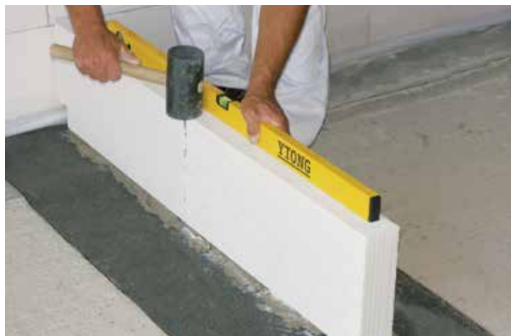
▲ Dbáme na rovinnost založení první řady, případné nerovnosti korigujeme poklepem gumovým kladivem.
