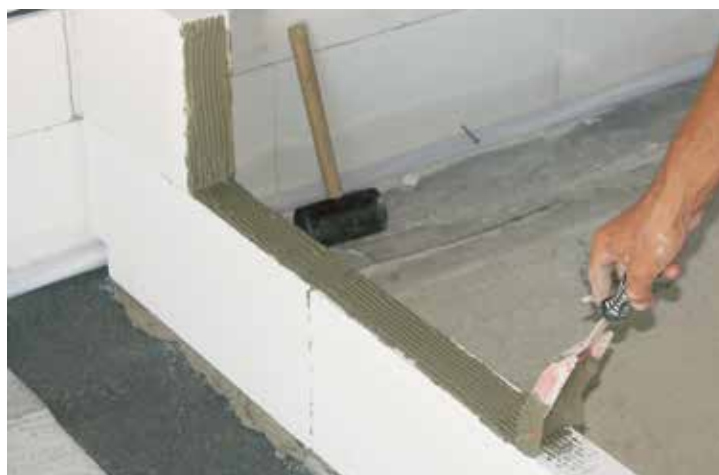
▲ Lepicí maltu nanášíme i na svislé spoje tvárnic. Vytvoření rohu v příčce je podobné pro všechny zdicí materiály. Dbáme na správné převazování tvárnic.
