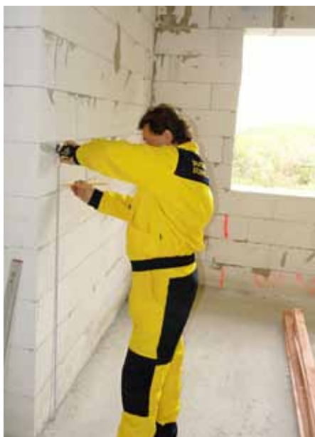
Vyměrování vypínačů v pórobetonu Ytong.
