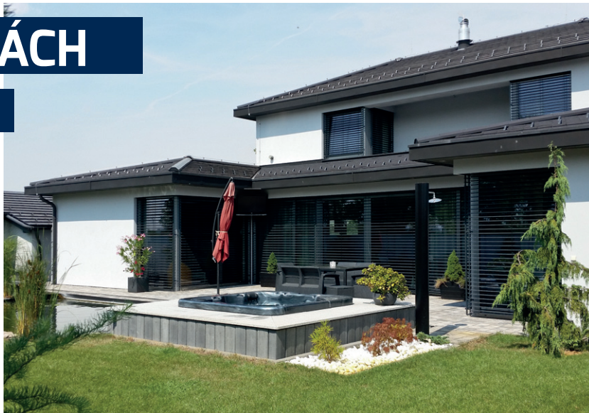
Realizace z Ytongu od Stakl stavby a střechy s. r. o.
