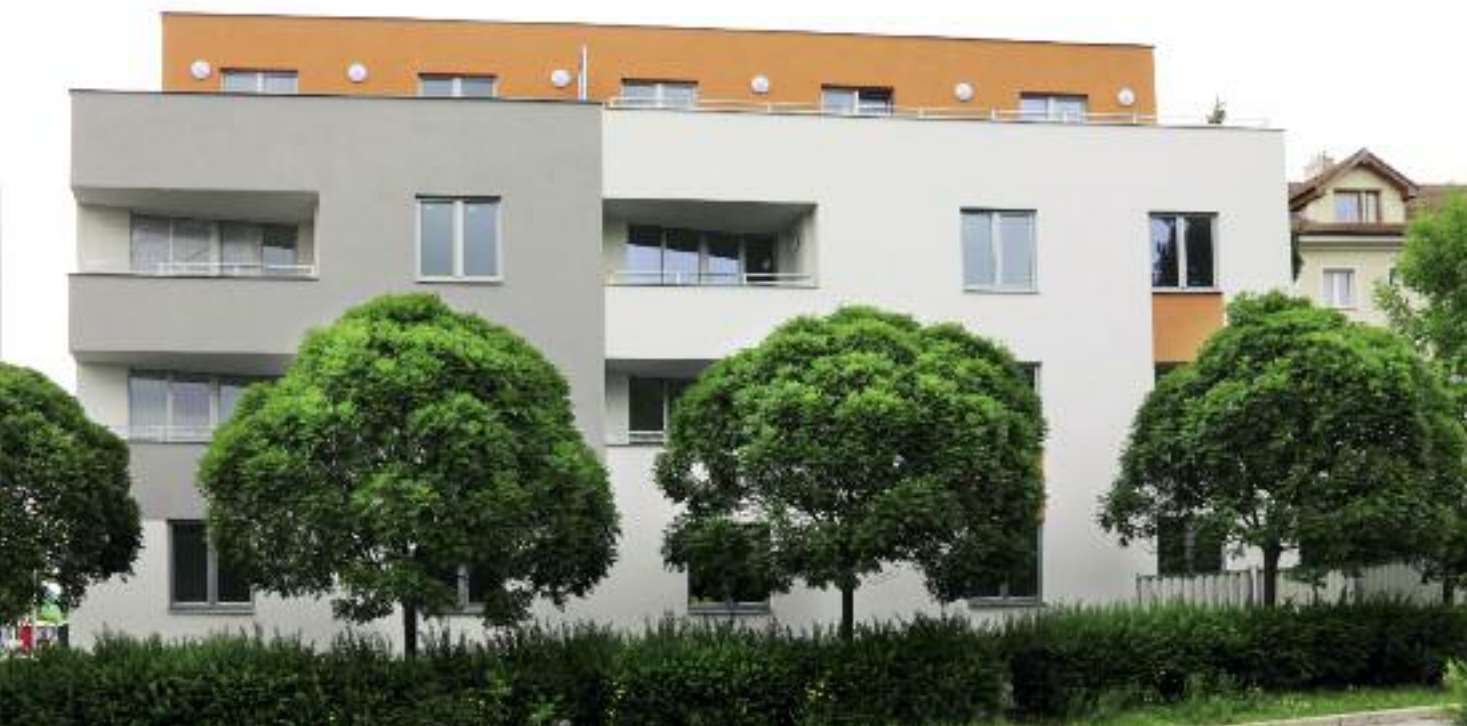
Bytový dům Ďáblice (Česká republika)
