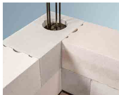
Vyzděné a vybetonované dvě vrstvy
