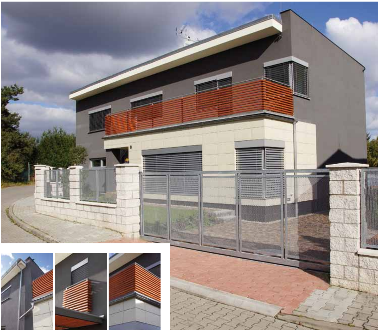
Z jihozápadní strany je dům často zalitý sluncem, a tak se tu hned od počátku počítalo s venkovními žaluziemi. Zábradlí na terase je ze sibiřského modřínu, plot ve směru do ulice z praktického, a přitom elegantního tahokovu.
