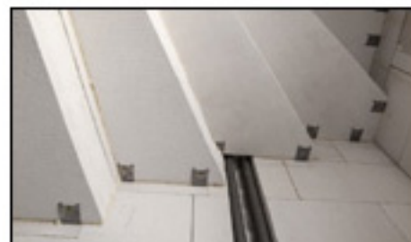
Obr. 3: Schodišťové stupně se osazují po obou dvou stranách
