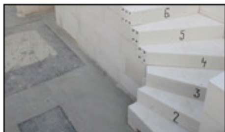
Obr. 2: Výstavba schodiště probíhá velmi rychle
