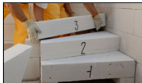
Obr. 1: Montáž schodiště s podezdívkou
