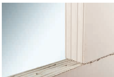
Uložení bloku do maltového lože
