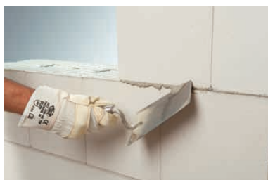
Po 24 hod odstranění přebytků zdicí malty
