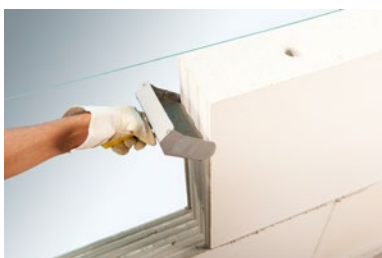
Maltování styčné spáry lžící
