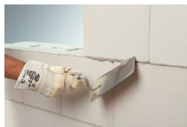
Po 24 hod odstranění přebytků zdicí malty
