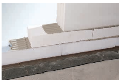
Založení první řady vápenopískového zdiva na tvárnici Ytong Start
