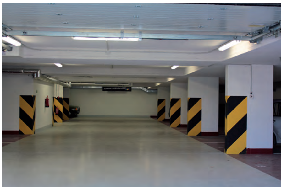
Obr. 4 Bytový dům Dolní Chabry
