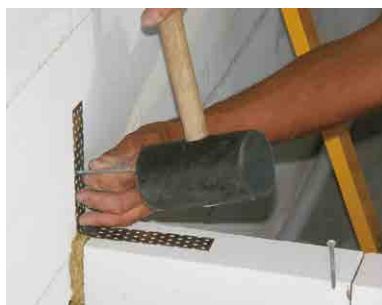
Dodatečná montáž spojky zdiva
