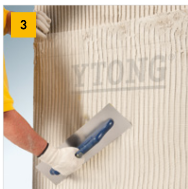
Vložení výztužné tkaniny Ytong
