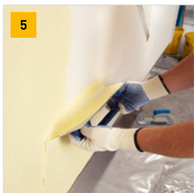
Nanášení finální vrstvy podle technologického předpisu výrobce
