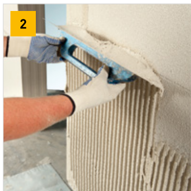
Nanášení první vrstvy vnější omítky tepelněizolační zubovou stěrkou se zubem 10 × 10 mm
