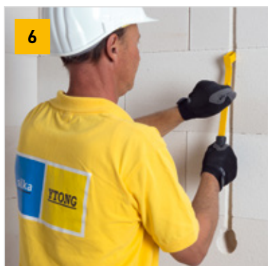
Vytvoření drážky pro elektroinstalaci a otvoru pro elektro krabici
