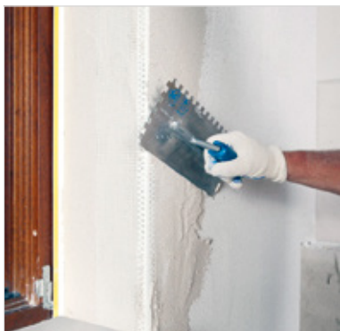
Instalace rohového profilu
