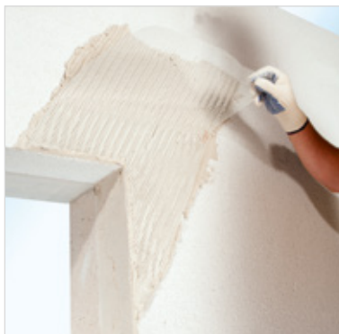
Provádění diagonální výztuže
